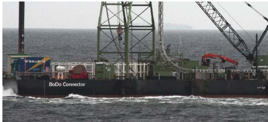
OFFSHORE. Für ein Flachwasserprojekt werden in der deutschen Bucht Kabel verlegt.
