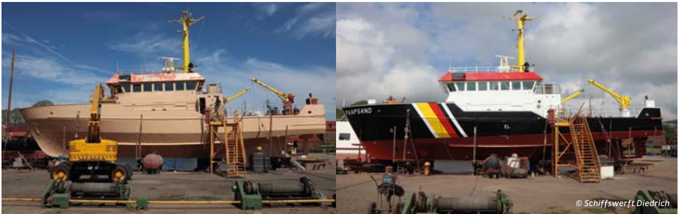
PAAPSAND: Nach aufwändiger Instandsetzung und Konservierungsarbeiten bald zurück in Fahrt
