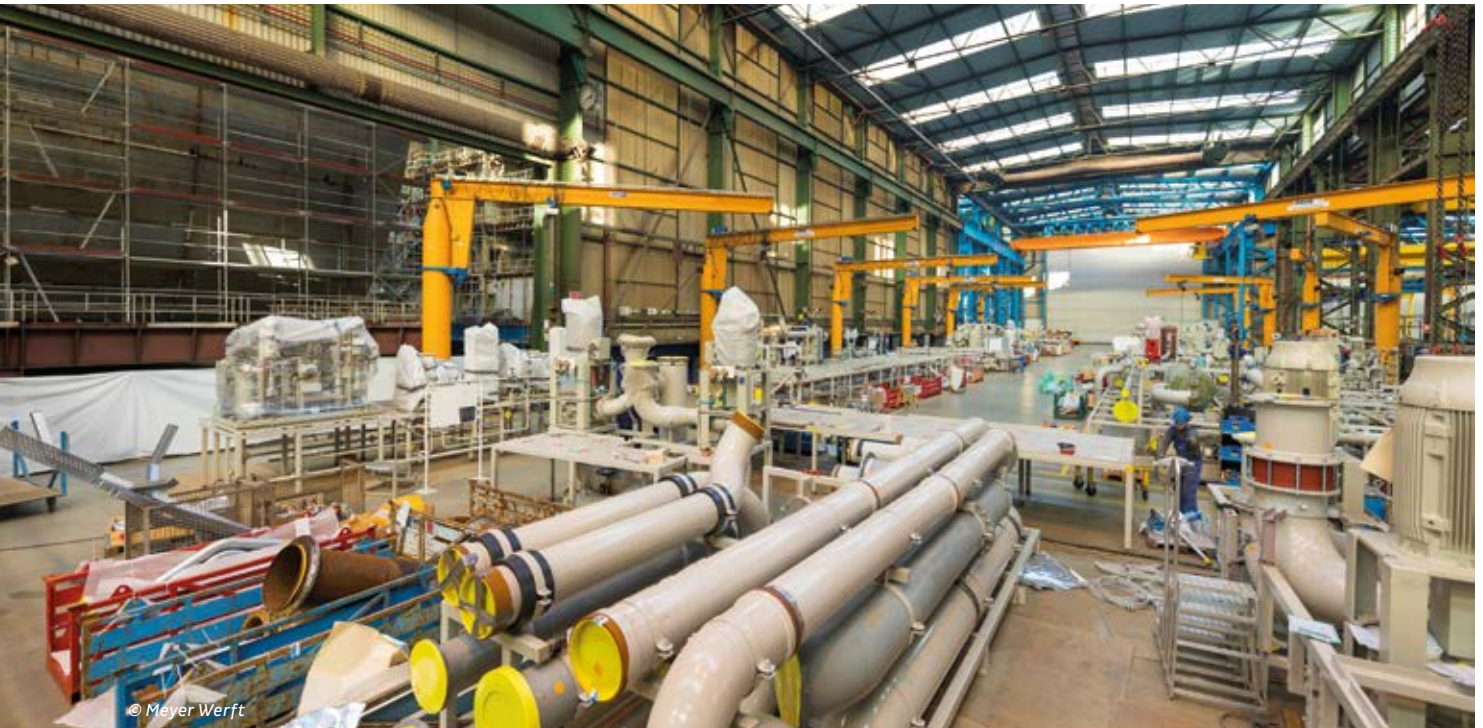
Rohrzentrum: Hier werden jährlich 300 km Rohr- und Kabelbahnstränge pro Schiff vormontiert
