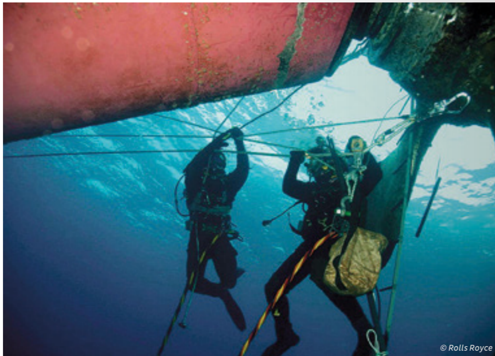
Bei dringenden Instandsetzungsarbeiten können Unterwasserreparaturen die Liegezeiten von Schiffen minimieren
